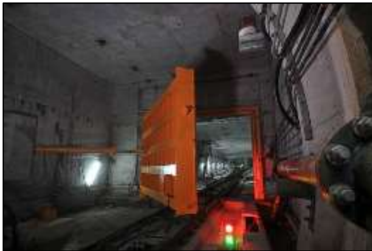
Une porte étanche permettant le cloisonnement du réseau
