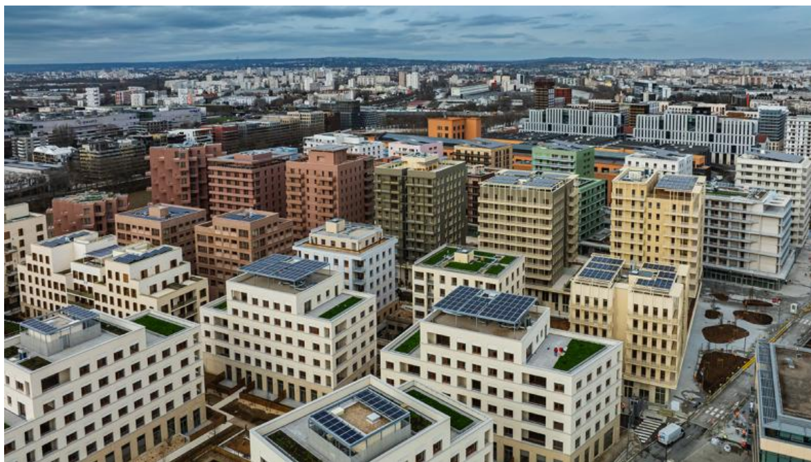
Photo issue de la SOLIDEO - Dronepress ( https://www.ouvrages-olympiques.fr ) représentant le secteur Belvédère du Village des athlètes
